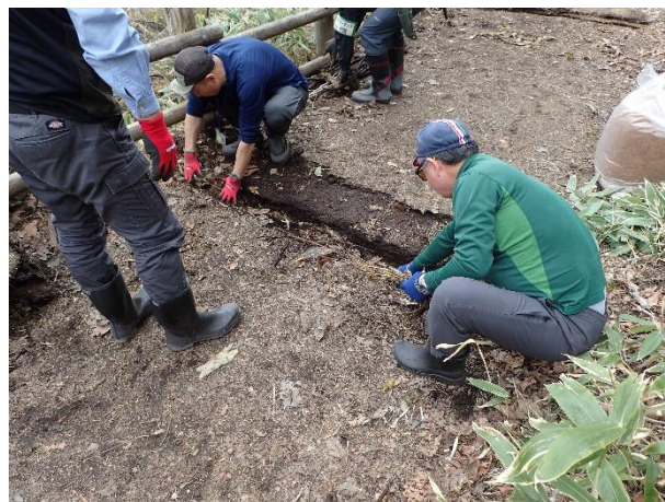
排水溝内に“そだ”（木の枝の束）を設置
