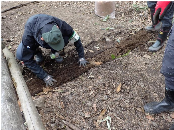
泥を除去し、繊維素材の土嚢をかぶせます
