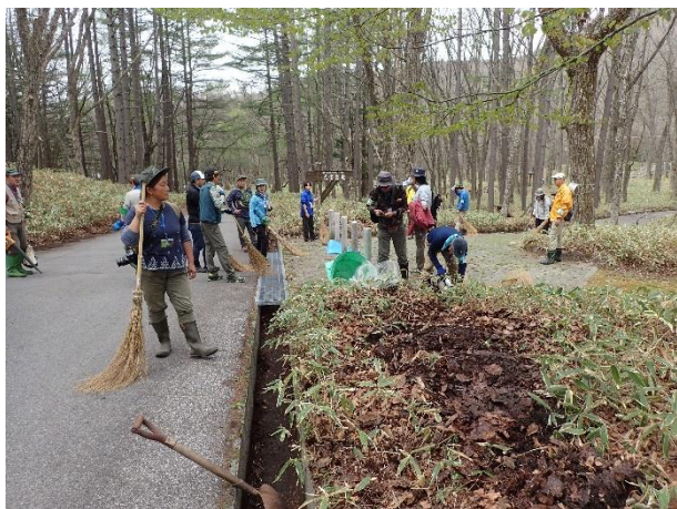
側溝に溜まった泥を取り出します
