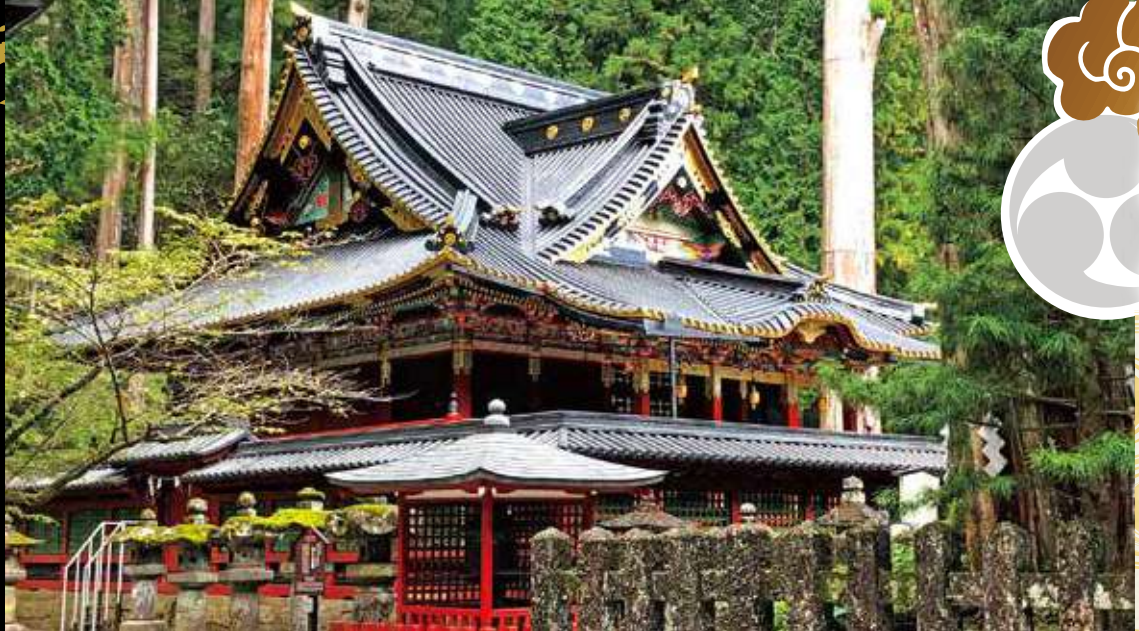
▲ 黒漆塗りの屋根、弁柄漆塗りの柱、鍔金具などの修理を終えて輝きを放つ本殿
